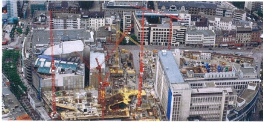
Großbaustelle PalaisQuartier in Frankfurt am Main.
