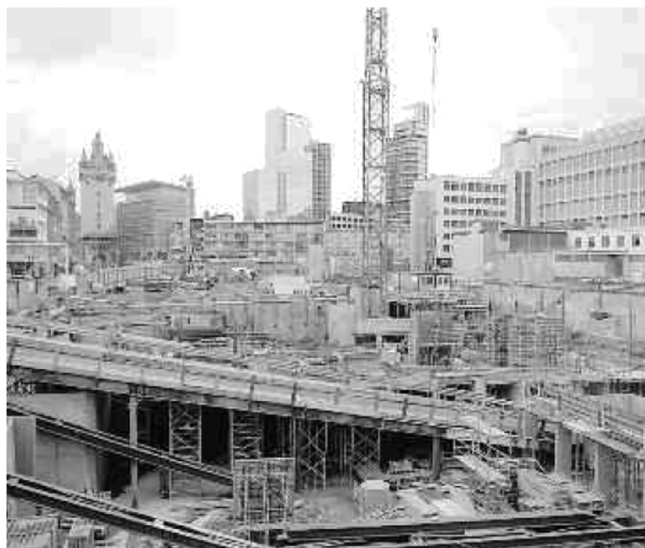
Um das Megaprojekt PalaisQuartier im Herzen Frankfurts zu stemmen, holte der Bauherr, die MAB Development Deutschland GmbH, bauserve mit ins Boot. Foto: PalaisQuartier
